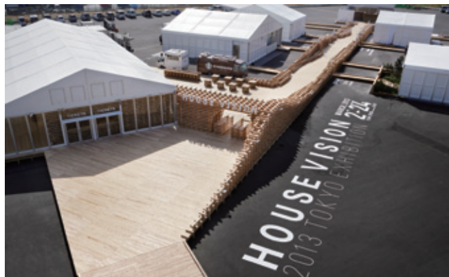
杉の角材が香る会場 角材は住友林業が調達・施工、終了後に東北復興へ活用されるということ 写真(上)Nacasa & Partners Inc.
